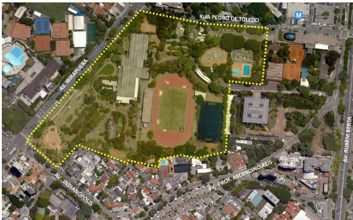
Figura 1 - Localização da área onde será implantada a Arena Esportiva e o Edifício Garagem.
